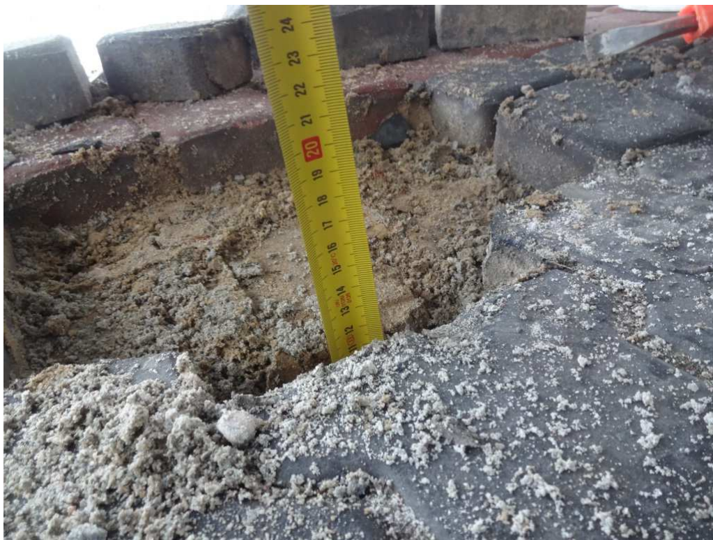
Fot.24. Odkrywanie warstw wykończeniowych na stropie znajdującym się przed wejściem głównym. Kostka brukowa 8cm i podsypka cementowo-piaskowa 5cm.
