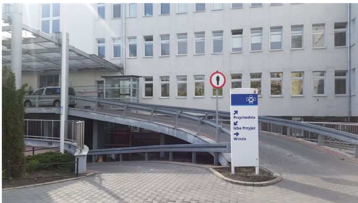
Fot.1. Widok na rampy wjazdowe przy wejściu głównym Szpitala na ul. Madalińskiego.
