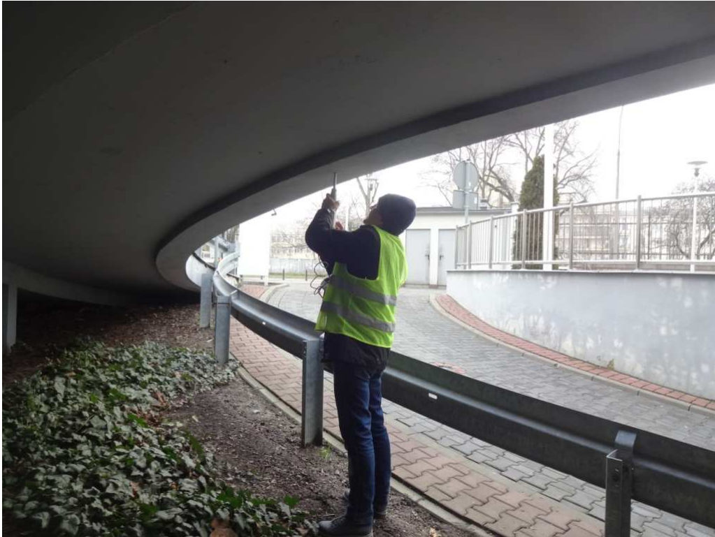
Fot.31. Jak wyżej, inne miejsce.
