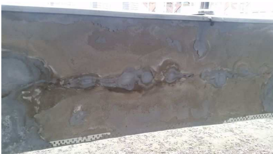
Fot.12. Próby naprawy warstwy licowej przez stosowanie różnych zapraw.
