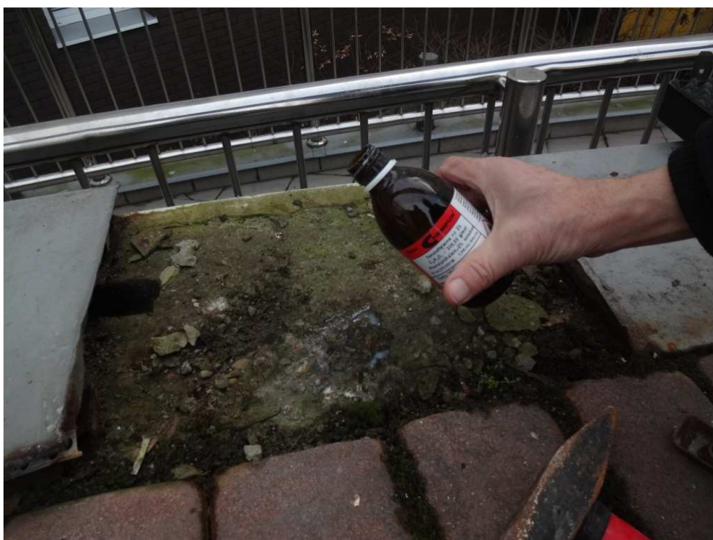
Fot.28. Badania stopnia skarbonatyzowania betonu przy użyciu fenoloftaleiny.
