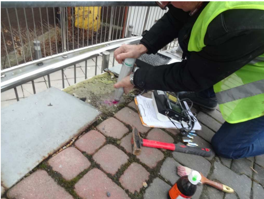
Fot.30. Badanie wytrzymałości betonu na ściskanie metodą sklerometryczną.
